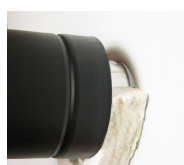
Isolera noggrant runt kopplingsstycket.
